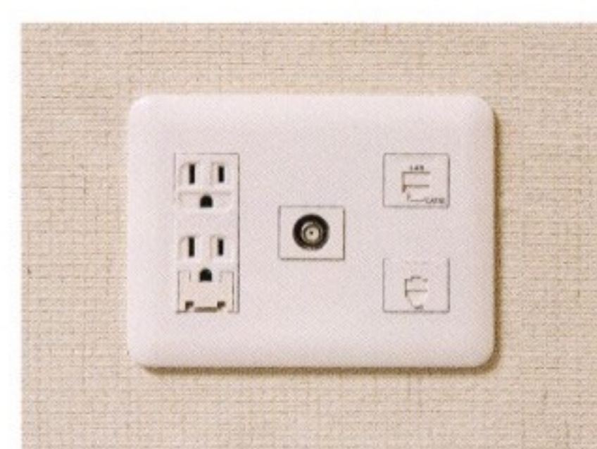
【マルチメディアコンセント】
